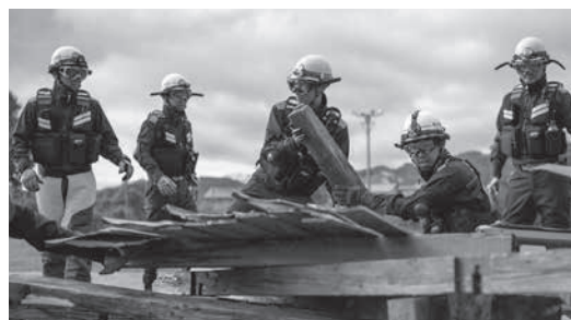
倒壊家屋救助訓練で木材を撤去する消防団救助隊員
