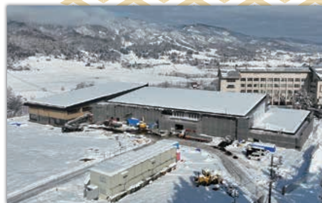
建設中の城北小学校新校舎（R6.12.20 撮影）
