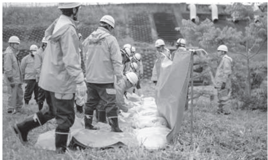
消防団が広井川排水機場付近で水防工法を実施
