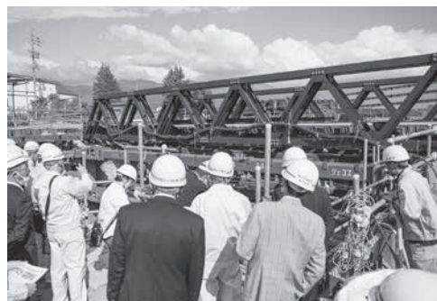
一級河川皿川改修工事の現地視察
