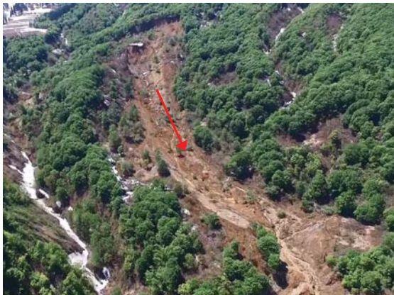
5月19日 崩落箇所
