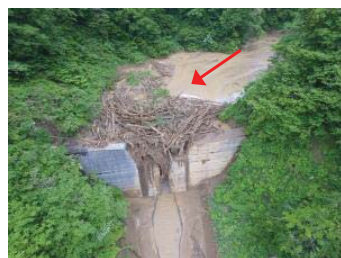
土石流を止めた桑名川砂防堰堤
