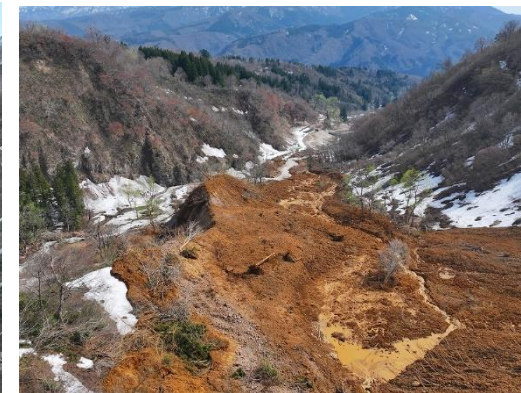
土砂崩落箇所上部から
