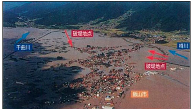
樽川の破堤状況 （出典:千曲川の洪水 千曲川河川事務所）
