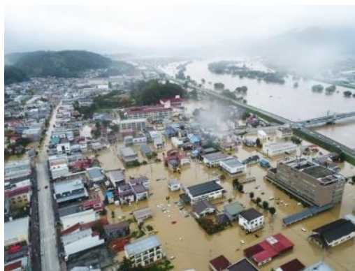
浸水被害状況
