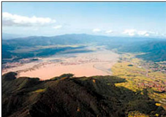
飯山市木島地区の浸水被害状況 （出典:WEB/信濃川水系）
