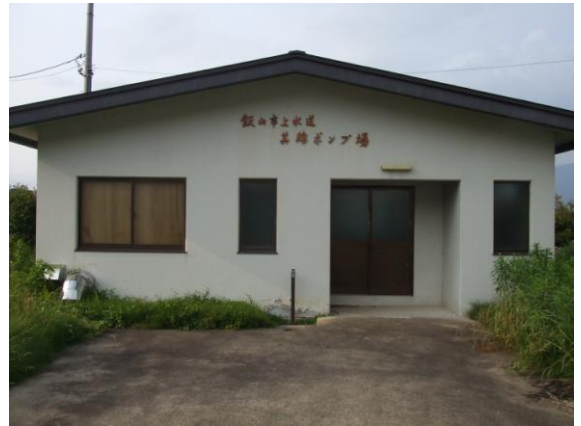
其綿ポンプ場
