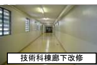
技術科棟廊下改修
