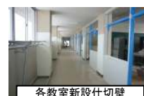
各教室新設仕切壁
