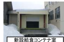
新設給食コンテナ室
