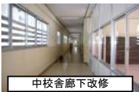
中校舎廊下改修
