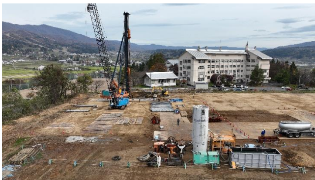
杭を打ち込むための大型重機により建築工事が進められている建設予定地の様子。(11月6日撮影)
