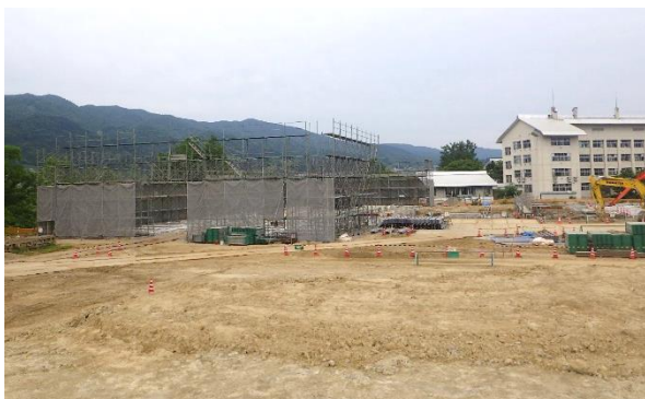
足場を組み鉄骨を立てる準備が進められている体育館
