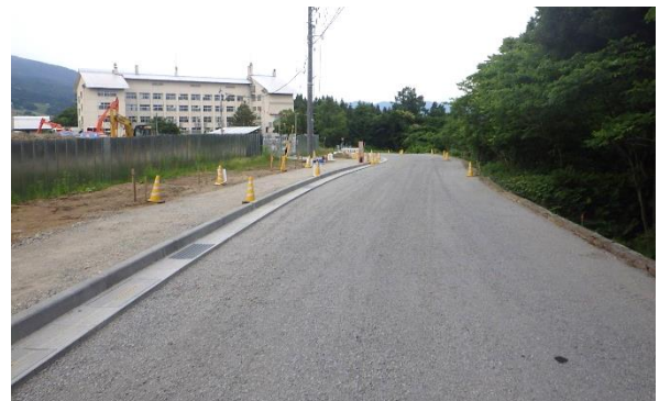
道路拡幅と歩道設置工事が進む市道7-317号
