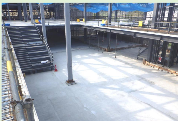
令和6年9月初旬の状況
