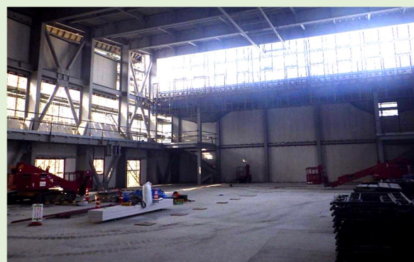
令和6年9月初旬の状況
