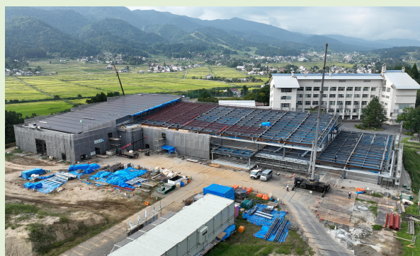
令和6年9月初旬の状況
