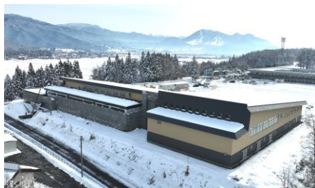
足場の一部が外れ、その姿が少しずつ見えるようになってきた城北小学校校舎建築工事の様子(R6年12月撮影)
