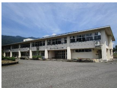
仮校舎として使用する戸狩小学校校舎
