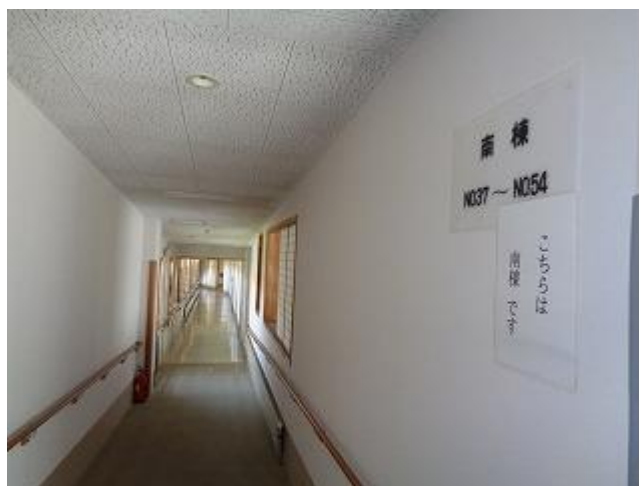
⑤養護老人ホーム南棟廊下
