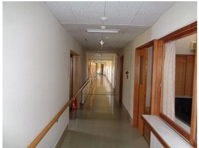
⑫養護老人ホーム中央棟廊下
