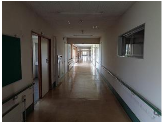
⑳特別養護老人ホーム北棟廊下
