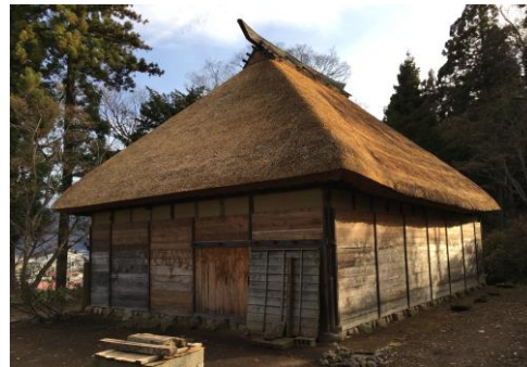
茅葺き屋根修繕後の正受庵
