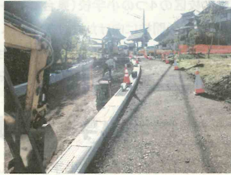
通学路となる市道では、歩道設置や車道拡幅などの改良工事も行っています（写真は城北中学校北方面）
