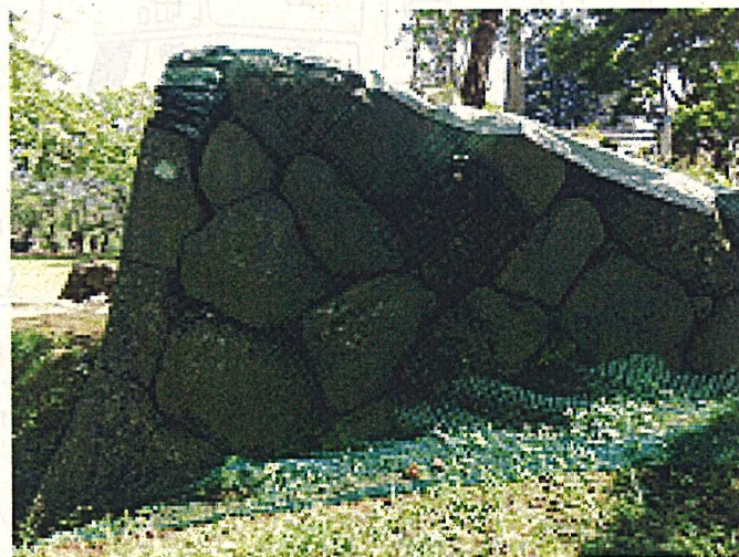
危険な隅石を取り外した状態（平成 28 年 9 月施工）
