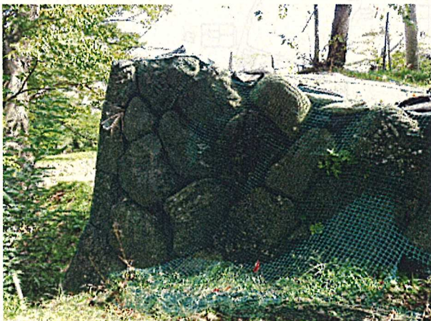
補強材を使って隅石を基に戻した状態（平成 30 年 7 月施工）
