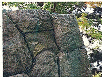
補強材を使って隅石を基に戻した状態（平成 30 年 7 月施工）
