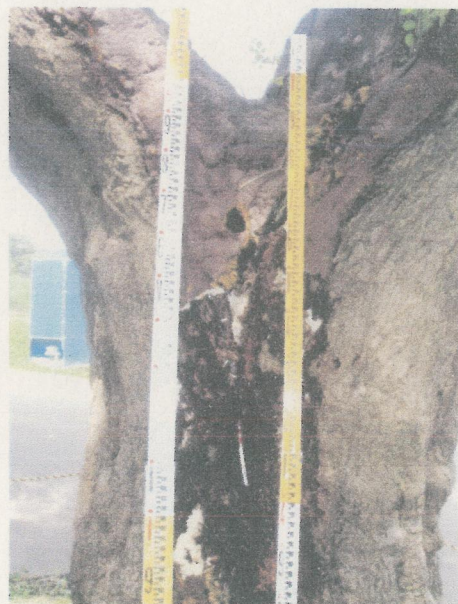
* 南側ウレタン除去後腐朽部深さ400
