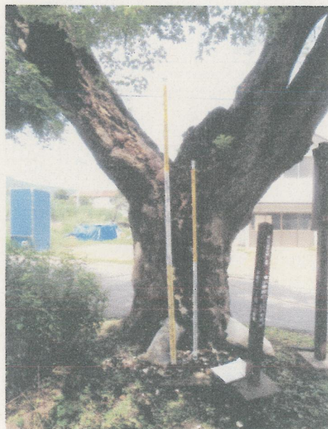
* 南側ウレタン除去状況
