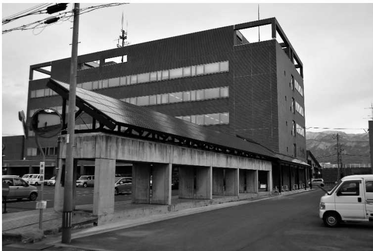
飯山市役所に設置された太陽光パネル (平成 23 年 12 月から稼働)
