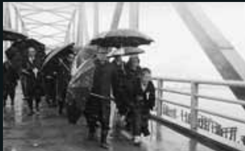
大関橋竣工 (S40年12月24日)
