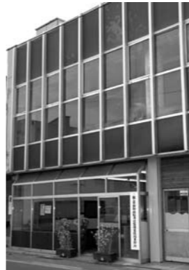
⑤県建築士会飯水支部の皆さんの協力もいただきながらの協働による改修工事でも、スライバーの空き店舗が見違えるほどきれいな姿に。
