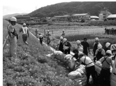
△千曲川の増水により常盤や木島では堤防から漏水。消防団が『月の輪工法』などで対応を行った。
