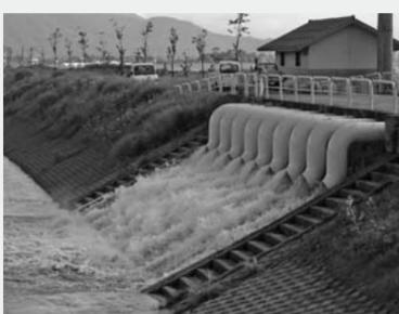
▷6月にポンプが2台増設されたばかりの、河川事務所広井川救急排水機場のポンプもフル稼働。被害を軽減した。(手前2つが増設したもの)
