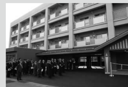
土木費 市営住宅 本町西団地建設
