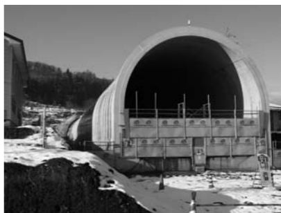
△新駅から飯山トンネル間も工事が進む
