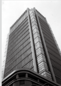
⑥カワモトのH型鋼が使われている丸ビル
