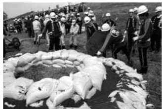
④釜段工法訓練。昨年の災害時対応状況をふまえ、今年度新たに実施。
