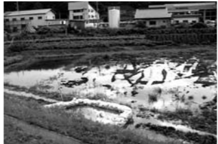
△昨年の豪雨災害では、数カ所で堤防が漏水。月の輪工法等で対応した。(写真は常盤小沼堤防)
