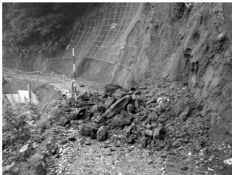
⑥土砂が一部崩落した市道(富倉地区)
