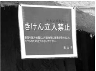
④土蔵等、損壊のひどい建物には「立入禁止」の看板も。
