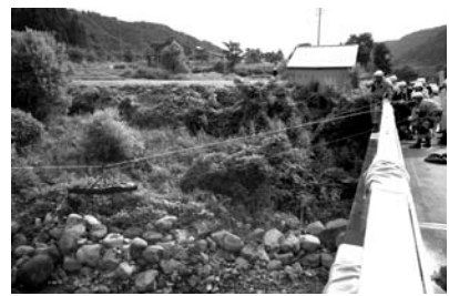
△救助・救出訓練。ロープを慎重に扱いながらも手際よく作業が行われた。
