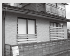
施工後 筋交い入りの壁を設けて、耐震強度を上げた
