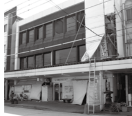
④開所を間近に控え改修工事が進む福祉センター（8月初旬撮影）
