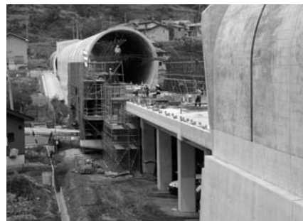
5 年後に向け順調に 市内の北陸新幹線工事は着々と進行。高架橋が架かるなど目に見えて間近に新幹線の到来を感じるようになりました。（写真㊶）
