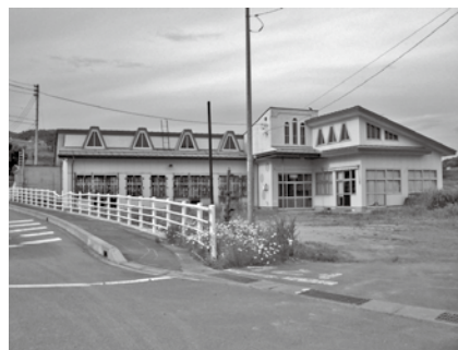
旧曾根保育園の外観（南側から撮影）
