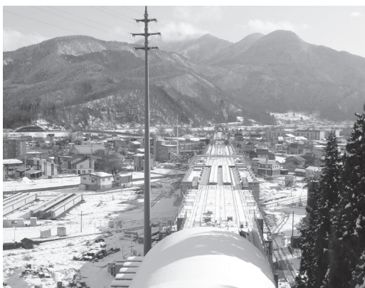
工事中の新駅舎
