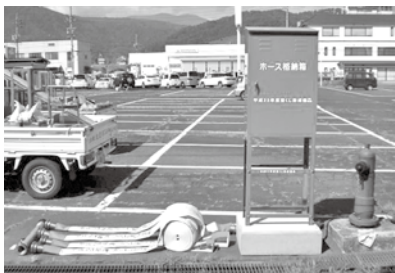
北畑区内 15 地点で消火栓器具箱や防火水そうの標識などが整備
