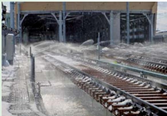
北陸新幹線の中野・飯山地区でも、同様の消雪システムが導入される事となっており、北陸新幹線第5千曲川橋りょう（菜の花大橋）から少し離れた綱切橋の上流に取水基地を建設して、千曲川の水を利用した消雪を行います。
