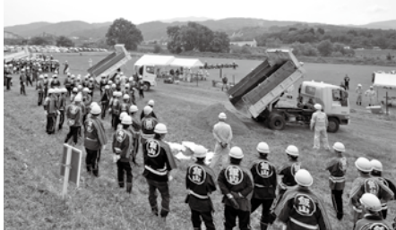
建設業協会の協力により、ダンプカー 3 台による資材搬入が行われた
