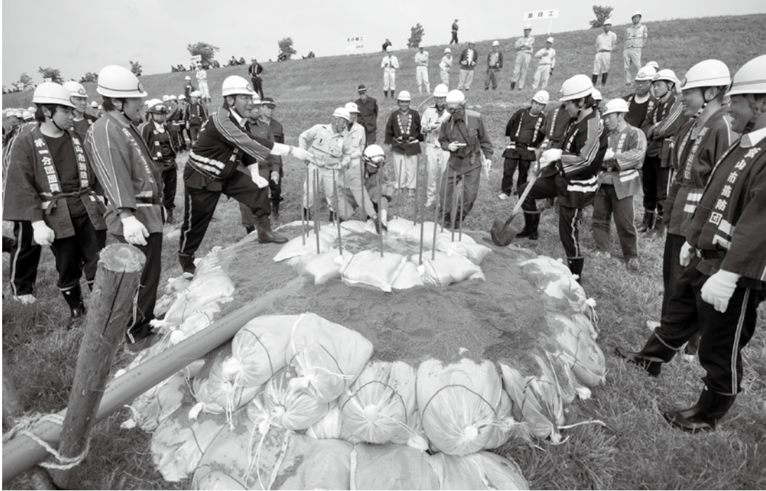
訓練により作成された釜段工法・月の輪工法へは実際に注水して効果を確認した
