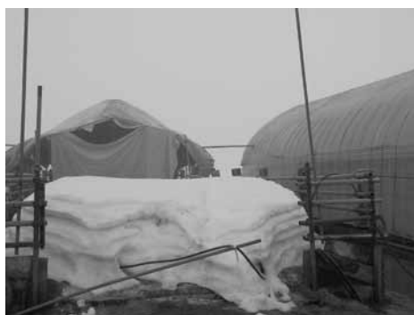
雪で倒壊した豚舎
