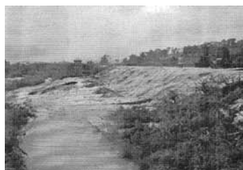
昭和57年9月 千曲川の増水により決壊5分前の樽川堤防
