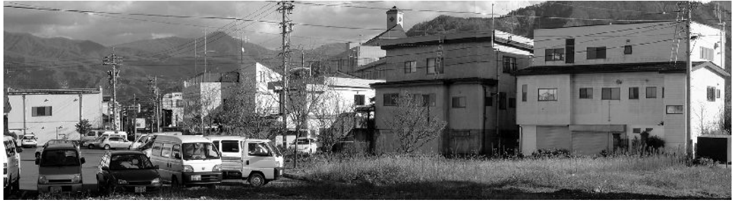
駅前広場敷地現況（飯山線から駅建設予定地を東南方面に望む）
