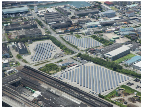
工業地域に設置された発電所
