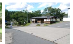
トイレと西入口の無散水 融雪道路
