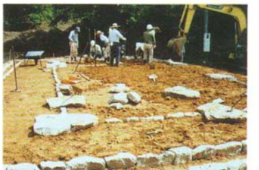
3 発掘された栗石の直上に礎石を配置（建物の範囲を右開いて表示）
