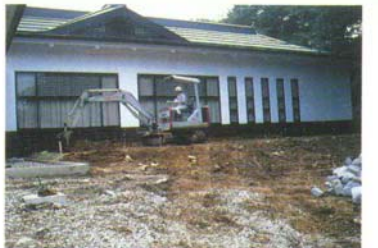
1 盛土面を平壇に仕上げる
