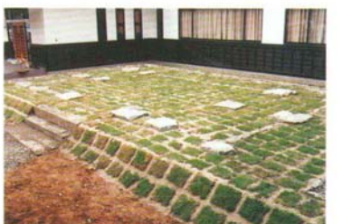
5 門入口に石段を設置して完成
