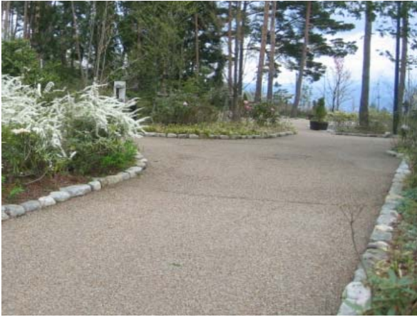
透水性脱色アスファルト舗装
