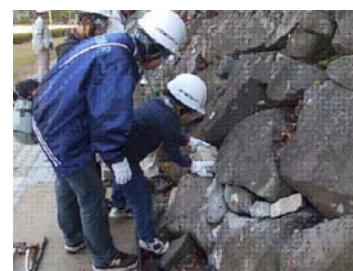
(事例：甲府城での詰石体験)
